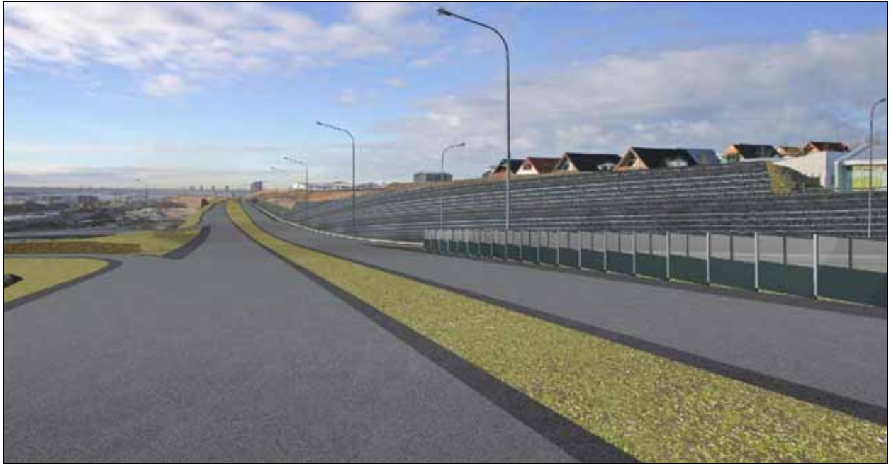
Mynd 2.9. Mynd tekin vestan við vegamótin við Strandgötu. Fyrirhuguð breyting á Reykjanesbraut, kostur 1 , sett inn á myndina. Reykjanesbrautin lækkar neðan við Hvaleyrarskóla á um 500 m kafla. Hliðrun neðan við Hvaleyrarholt er ekki sýnd.
