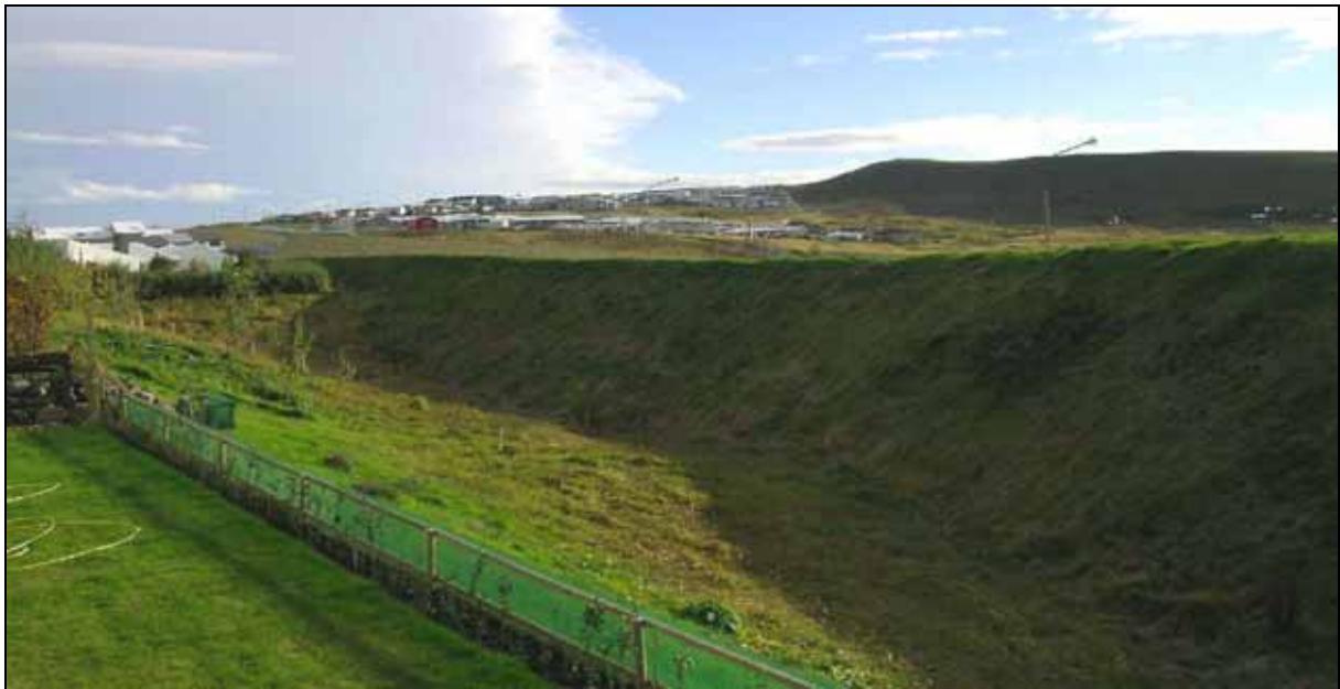
Mynd 5.29 Mynd tekin við Vallarbarð 19-21 og sýnir kost 1 , það er núverandi hljóðmön og gabíon hljóðmanir meðfram lækkaðri Reykjanesbraut fjær (ljósmynd: Mannvit 2006).
