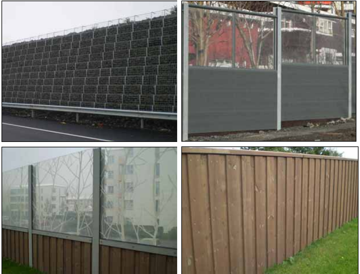
Mynd 5.5 Gabíon hljóðmön (efst til vinstri). Dæmi um útlit hljóðveggja, úr gleri og áli (efst til hægri), úr gleri og timbri (neðst til vinstri), úr timbri (neðst til hægri) (ljósm.: Mannvit hf., 2007).
