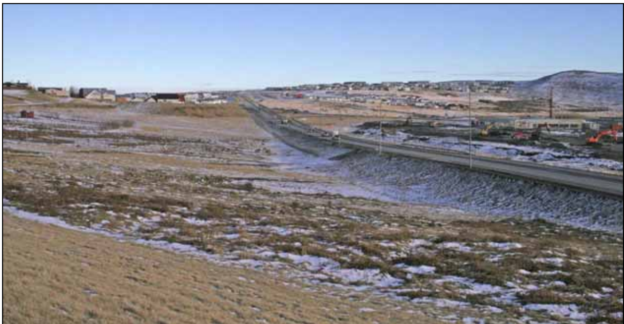
Mynd 5.31 Mynd tekin austan við Hvaleyrarskóla og sýnir núverandi Reykjanesbraut (ljósmynd: Mannvit 2007).
