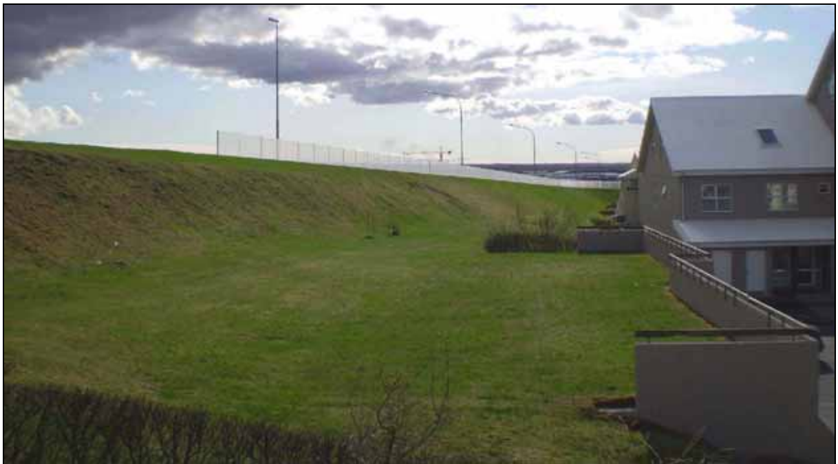
Mynd 5.13 Mynd tekin við Fagrahvamm 4 og sýnir kost 1 , það er 2 m háan hljóðvegg úr gleri ofan á nýrri 2 m gabíon hljóðmön og lækkaða Reykjanesbraut (ljósmynd: Mannvit 2007).
