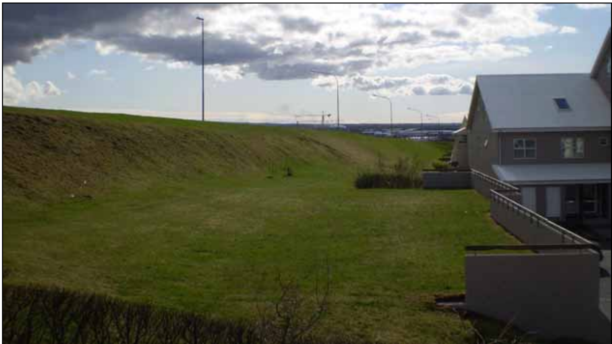
Mynd 5.11 Mynd tekin við Fagrahvamm 4 og sýnir núverandi hljóðmön, um 2 m háa yfir vegi, meðfram Reykjanesbraut (ljósmynd: Mannvit 2007).
